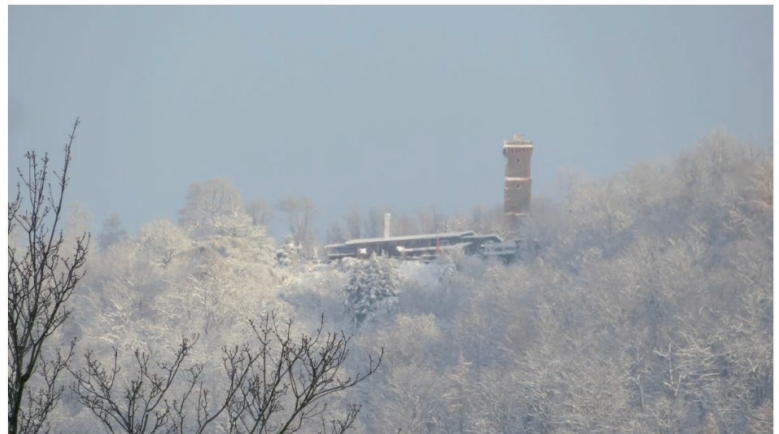
Wintermärchen auf dem Bismarckturm Bad Lauterberg. Möglichst bald will der örtliche Harzklub das denkmalgeschützte Bauwerk sanieren lassen.
