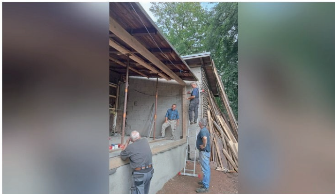
Bei der Fassadensanierung. Die Außenwand an der Jägerstube musste komplett neu gebaut werden, mit einem neuen Betonfundament.
